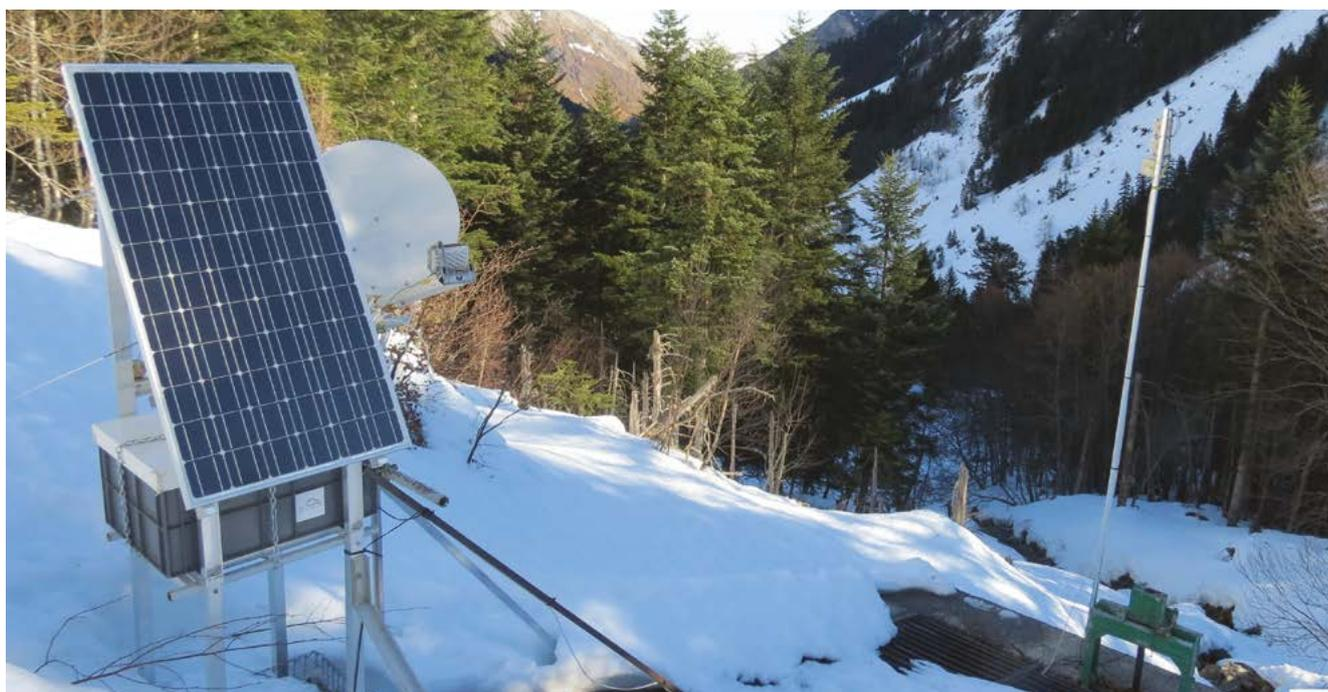
Un des projets présentés sur le site Innopy : module solaire LeanConnected pour connecter une prise d'eau EDF dans les Pyrénées.
